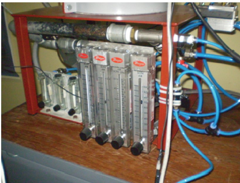
Figura 0.10 - Detalhe dos rotômetros na fase de teste
